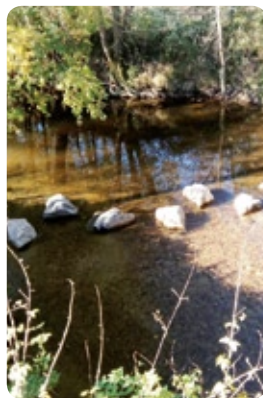
SEPTEMBRE Réfection du passage à gué de la ronde Madeleine
