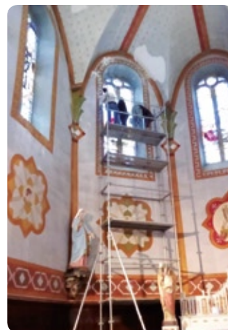
DÉCEMBRE Début des travaux de restauration des vitraux de l'église
